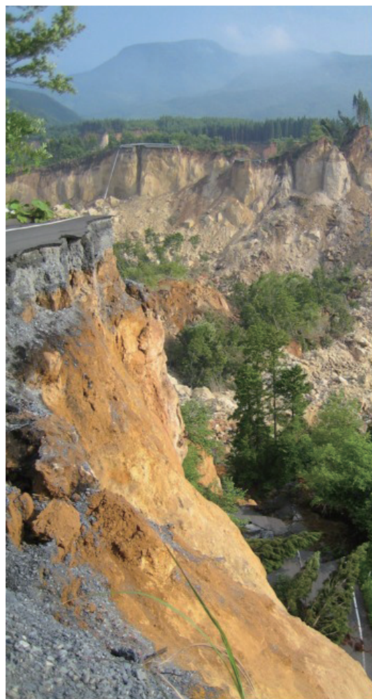
2008年岩手宮城内陸地震による 荒砥沢ダム上流部の崩壊
