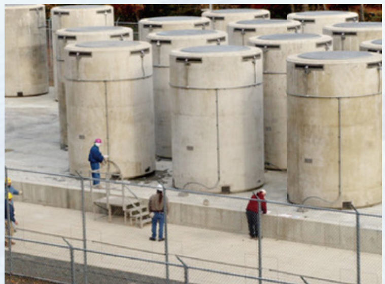
コンクリートキャスク貯蔵 (コネティカットヤンキー原子力発電所)
