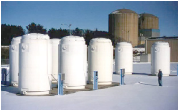
図2-4 米国における金属キャスク貯蔵施設 5) (Prairie Island発電所)
