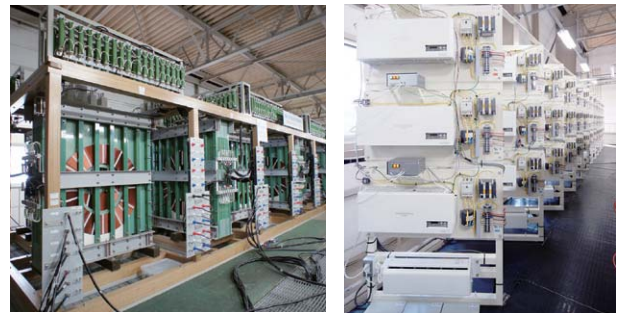
(左:66kV 模擬送電線, 右:太陽光発電用PCS) 図2-6 太陽光発電大量導入時の系統事故時の現象を検証するためのシュミレーター設備
