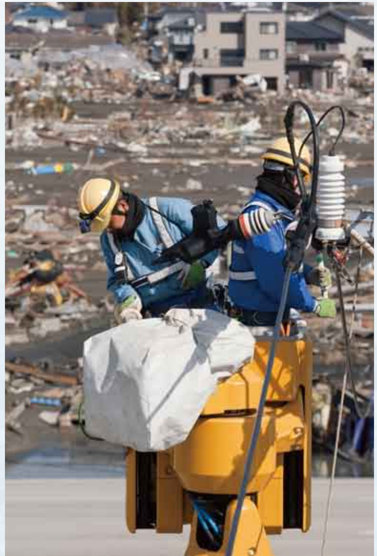
石巻市内での復旧作業 写真提供:東北電力株
