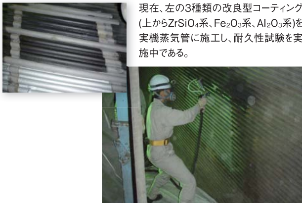
図3-3 耐硫化腐食コーティングの実証試験
