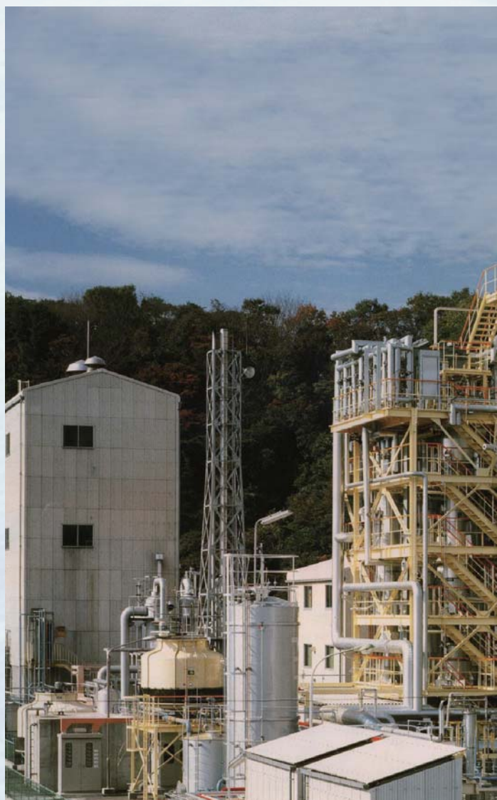
当所 横須賀地区に設置された 2トン／日石炭ガス化実験設備(左奥) — IGCC実証機の原型炉
