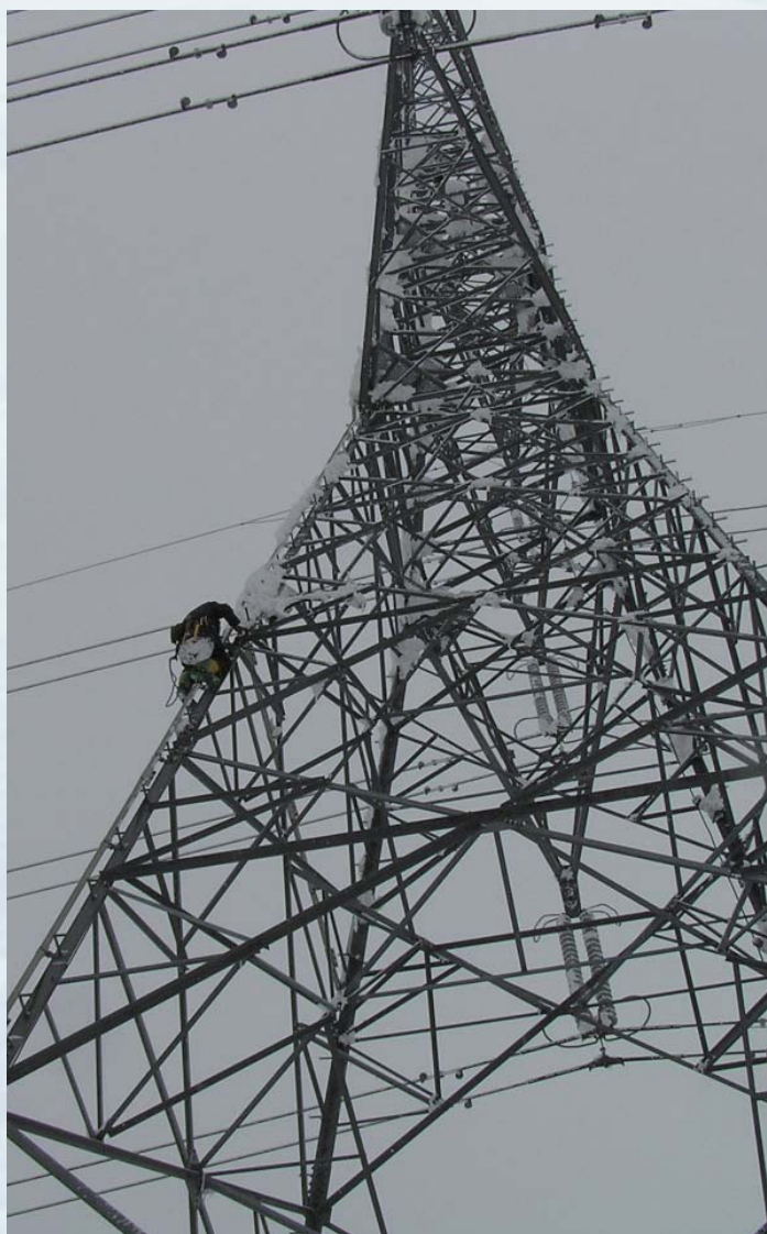
降雪下に送電鉄塔を点検する作業員(北海道電力提供)
