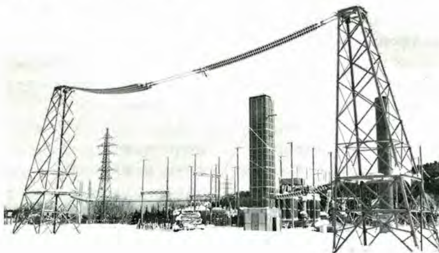
図3-4-4 開閉インパルス実験設備全景
