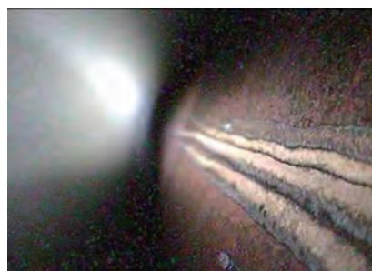
(キャニスタ中央部溶接線付近)
