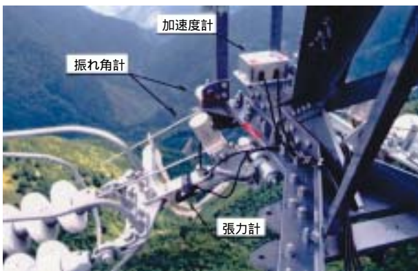
写真4-1-2 四国試験線No.2腕金先測器取付状況
