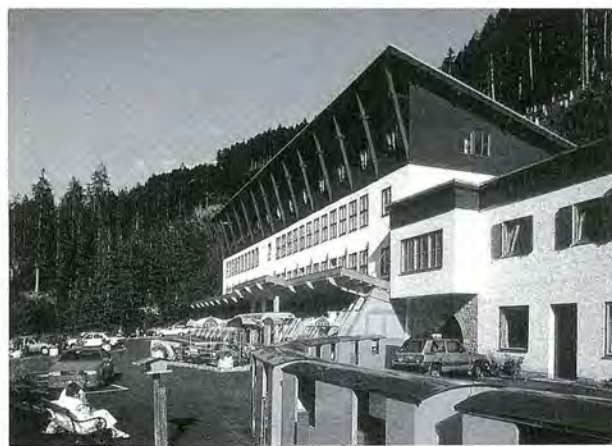
写真1-3-2 温熱坑道への入り口 手前のトロッコに乗って入坑する
