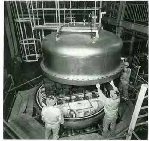
図4-1-7 10kW級スタックの据付け状況
