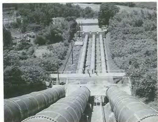
写真4-1-1 水力鋼構造物（上からラジアルゲート、ローラーゲート、水圧鉄管）
