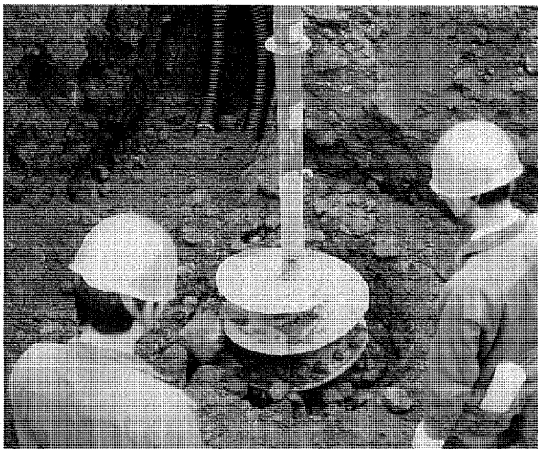
写真2-2-3 大口径（75cmφ）アースオーガによる掘削
