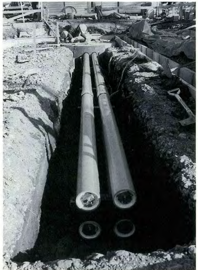
写真2-1-1 ケーブル防護管の歩道下30cm浅層埋設状況
