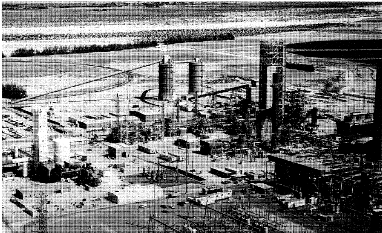
図4-1-1 クールウォーター実証プラント全景
