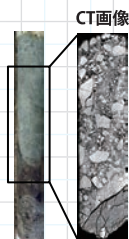
観察したボーリングコア試料断層破砕帯の内部構造
