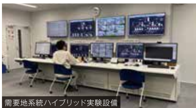
需要地系統ハイブリッド実験設備
