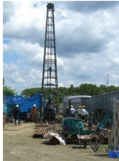
図-3 観測点(HKD020)でのボーリングの様子
