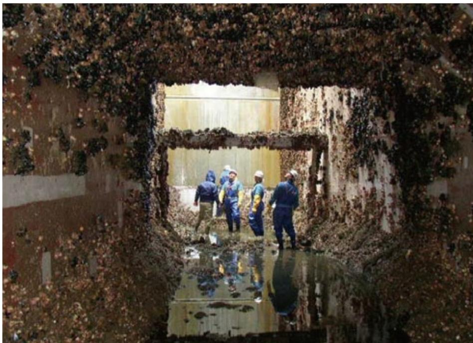
発電所冷却水路の付着生物
