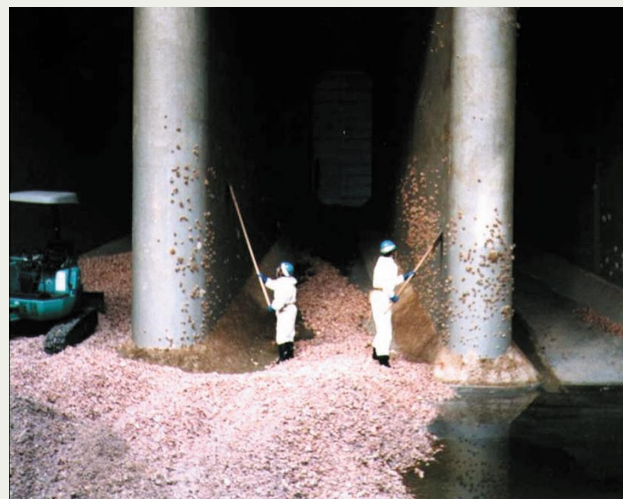
取水路入口付近でのムラサキイガイとアカフジツボの除去作業の様子。
