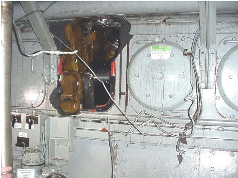
図 3.2-1 : 損傷した非常用ディーゼル発電機
