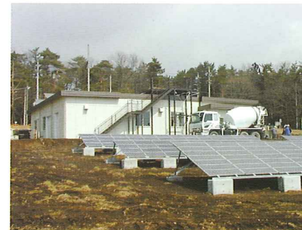
主電源室と太陽光パネル
