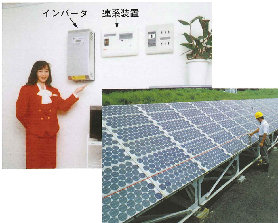
単結晶5kWの太陽電池
