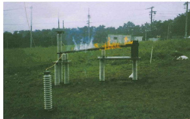
樹木接触による地絡試験
