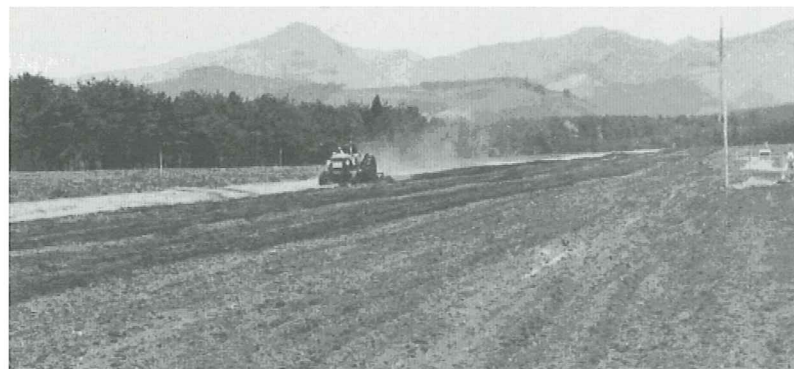
大型機械導入による畑地の造成
