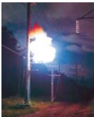
20~30kV配電実験設備(S44年・赤城)
