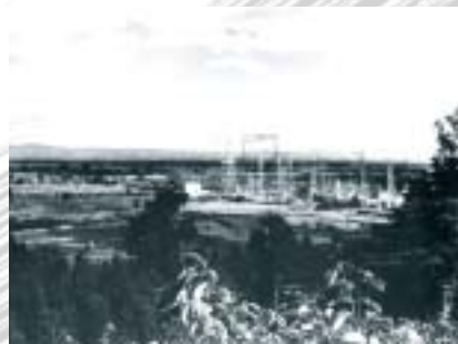
400kV級送電線路用実証研究のための実験場完成(S36年・塩原)
