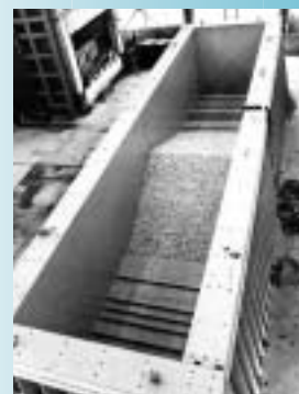
大規模フィルダムの耐震安定性などの振動台実験 (S45年ごろ～)
