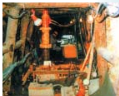
原子力発電所立地地点調査における抗内の岩盤試験 (S45年ごろ)
