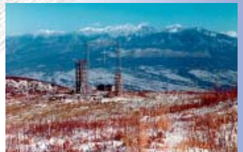
長野県・入笠山における500kV高地送電線の絶縁試験 (S41年)
