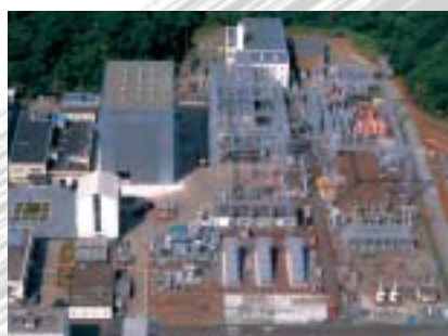
大容量電力短絡試験設備を改修 (H6年)
