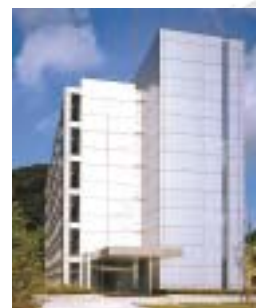
横須賀研究所本館が竣工(H8年)
