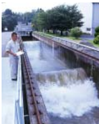
実規模波浪模擬実験のできる大型造波水路 (S54年)
