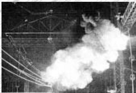
がいし連の400kV級耐アーク試験(S39年)
