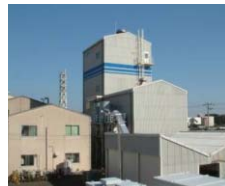
設備建屋外観
