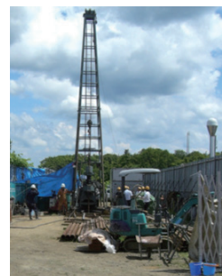
ボーリング調査
