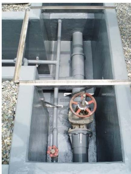
再発防止工事(排水管更新、U字溝設置)
