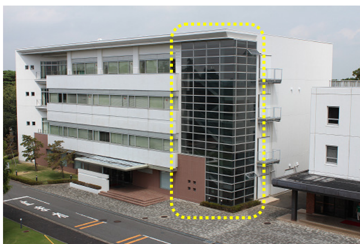
遮光フィルムの施工例(点線部分)
