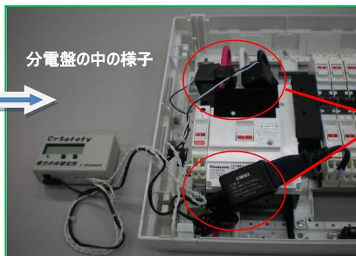
電流を測定するためのセンサーと電源を取り付けるだけ。
