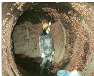
写真-1 発電所の取水路には、フジツボやムラサキガイなどが付着するので、定期的に除去します。
