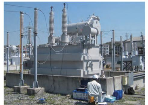
FRAによる変圧器巻線異常診断の様子
